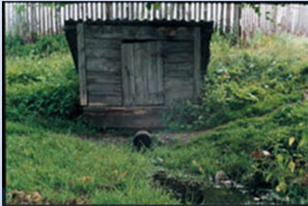
с. Старая Рачейка. Сызранский район. Выше родника расположены огороды, жилая застройка. Используется для нецентрализованного хозяйственно-питьевого водоснабжения.
